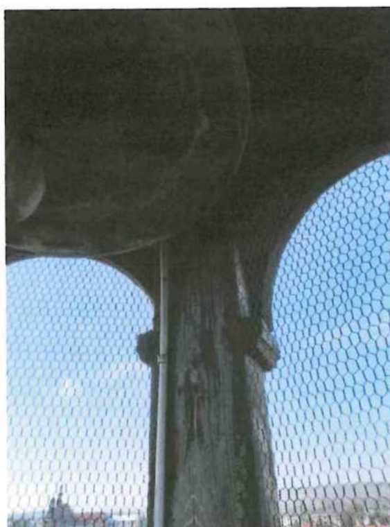
Zdj. nr 3. Zawieszony dzwon. Widoczny słupek dzwonnicy i osiatkowanie
