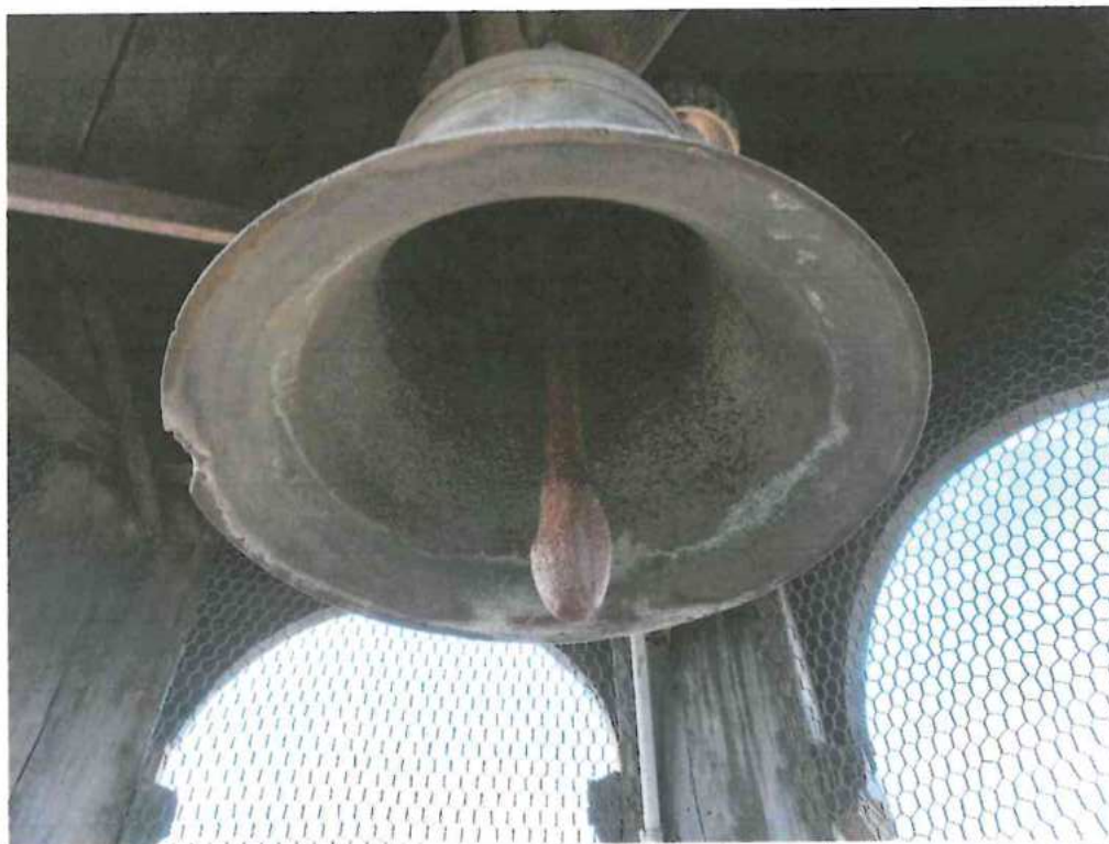
Zdj. nr 4. Konstrukcja drewniana dzwonnicy z elementem ruchomym zawieszonoego dzwonu. Widoczne łukowe połączenia słupów w ich górnej części.
