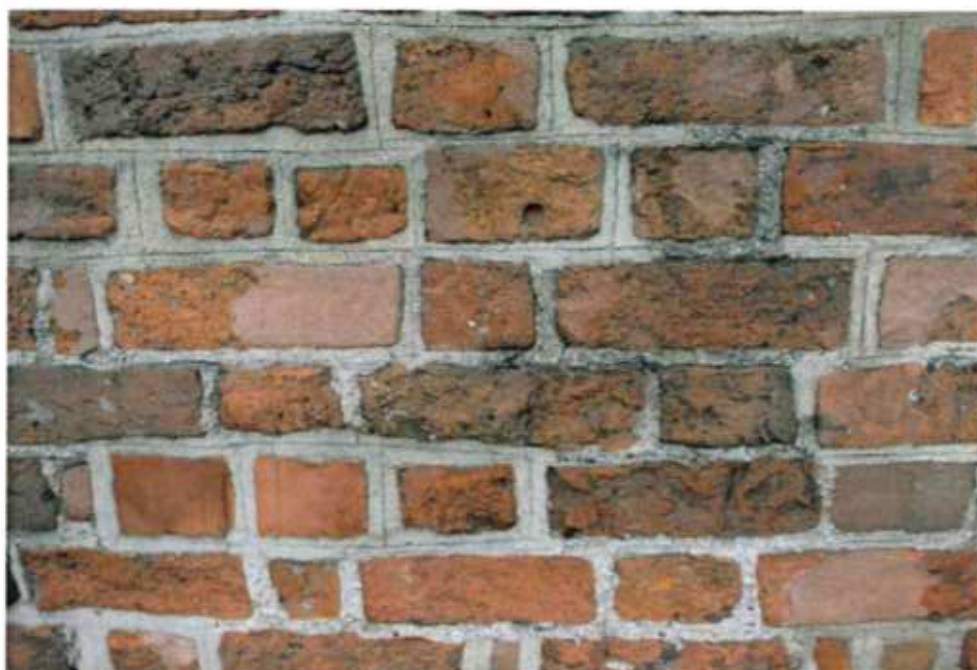
Analogia wykonawcza - wątek ceramiczny gotycki, fragmenty oryginalnej spoiny, kościół p.w. Św. Trójcy, w Gnieźnie.
