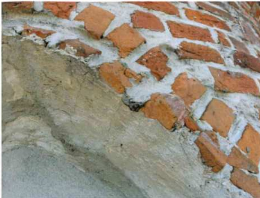
Ilustracja 35: Białkowana wyprawa tynkarska blendy, uzupełnienia zaprawą cementową
