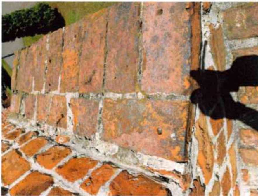
Ilustracja 19: Erozja szkarp, atak biologiczny, spoiny cementowe
