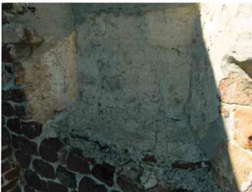
Ilustracja 30: Erozja średniowiecznych i współczesnych wypraw tynkarskich
