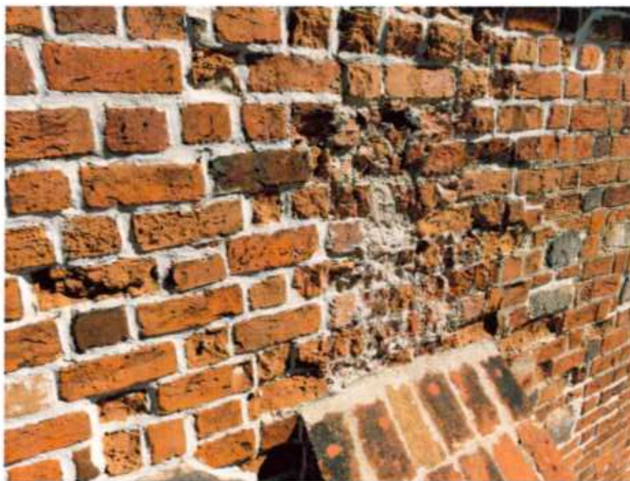
Ilustracja 1: Erozja materiału ceramicznego w miejscu skutych szkarp późnogotyckich
