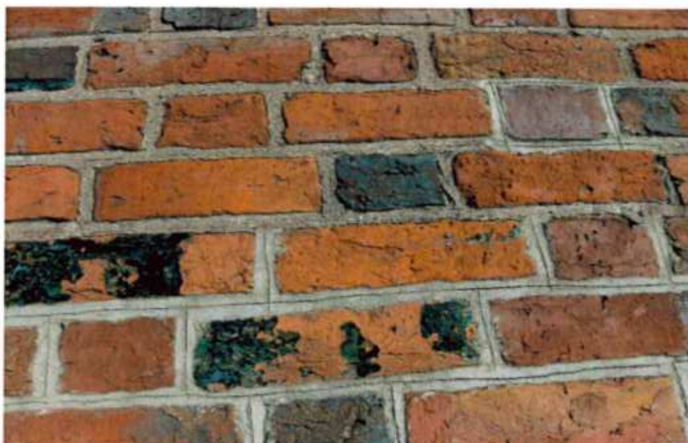
Analogia wykonawcza - watek ceramiczny gotycki, fragmenty oryginalnej spoiny, kościół p.w. N.M.P. w Poznaniu.
