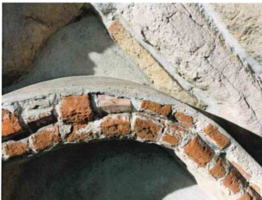
Ilustracja 24: Erozja piaskowca w portalu romańskim, zacierki z zaprawy Tubag
