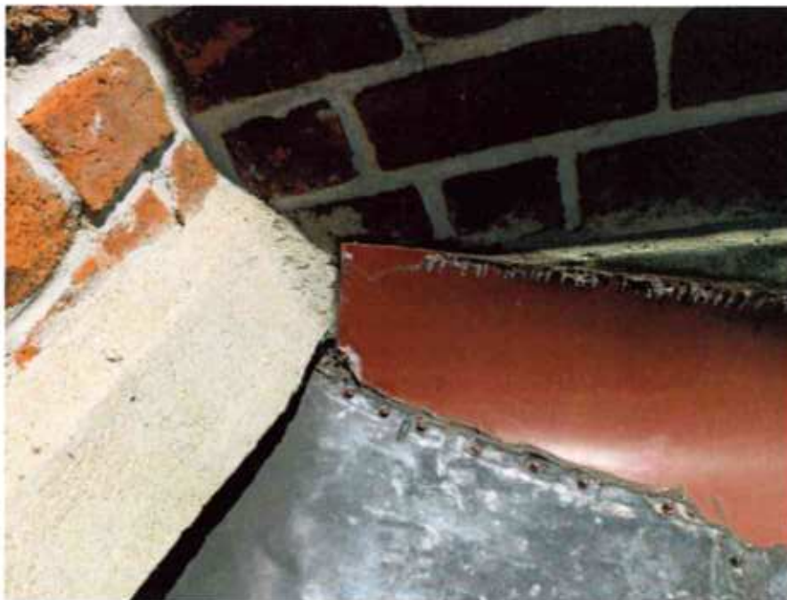
Ilustracja 15: Stalowe opierzenia na dachu kruchty
