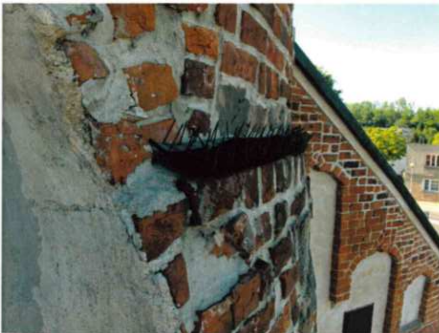
Ilustracja 36: Zabezpieczenia przeciw ptactwu na uskoku apsydy
