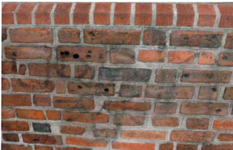
Analogia wykonawcza - wątek ceramiczny gotycki, fragmenty oryginalnej spoiny, kościół p.w. Św. Trójcy, w Gnieźnie.
