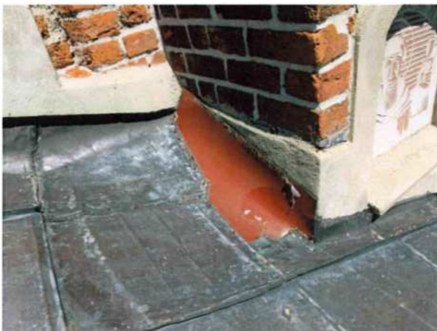
Ilustracja 14: Stalowe opierzenia na dachu kruchty
