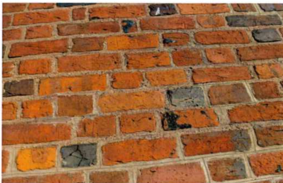
Analogia wykonawcza - wątek ceramiczny gotycki, fragmenty oryginalnej spoiny, kościół p.w. N.M.P. w Poznaniu.
