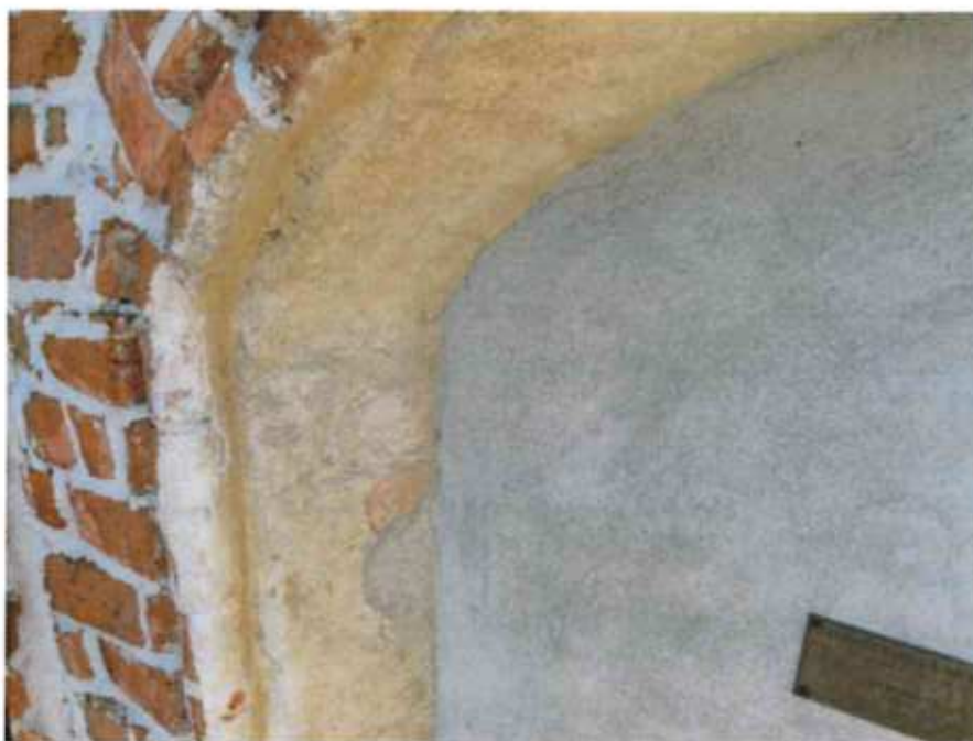
Ilustracja 22: Wyprawy cementowe w portalu gotyckim
