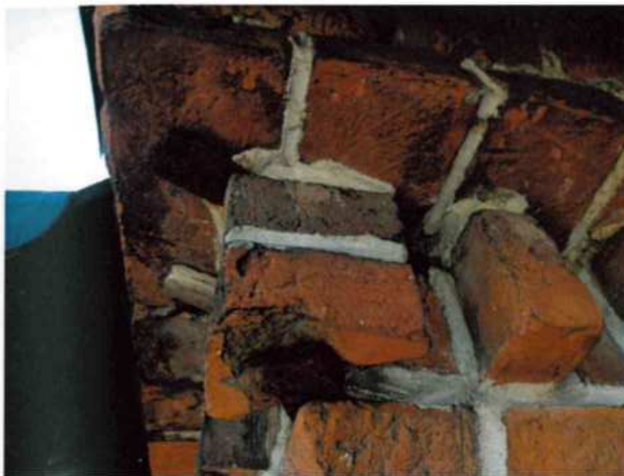
Ilustracja 31: Mocowania gipsu kostkowego w koronie murów
