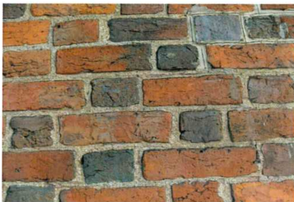
Analogia wykonawcza - wątek ceramiczny gotycki, fragmenty oryginalnej spoiny, kościół p.w. N.M.P. w Poznaniu.
