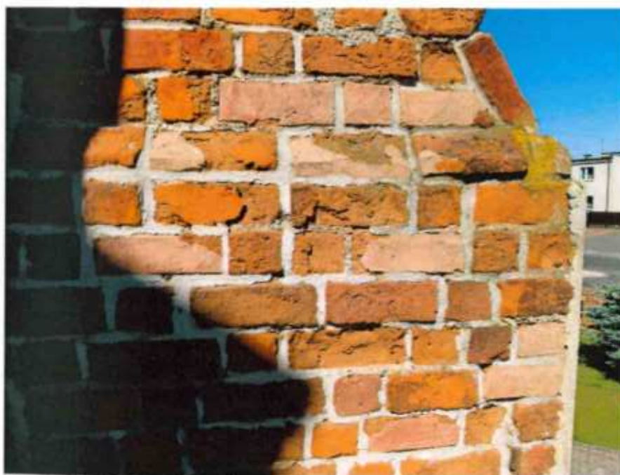
Ilustracja 32: Erozja wątku ceglanego, atak biologiczny, wyprawy masą Atlas, spoiny cementowe
